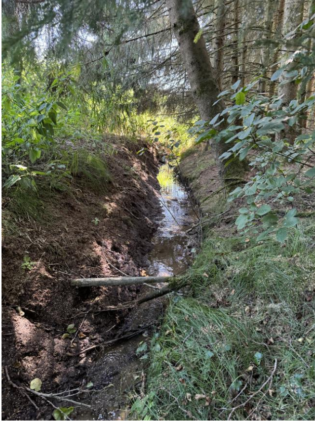
Abbildung 3: Ortseinsicht Pfarrgraben im Bereich Flurnummer 48/3 (Vorort-Besichtigung vom 31.07.2024)
