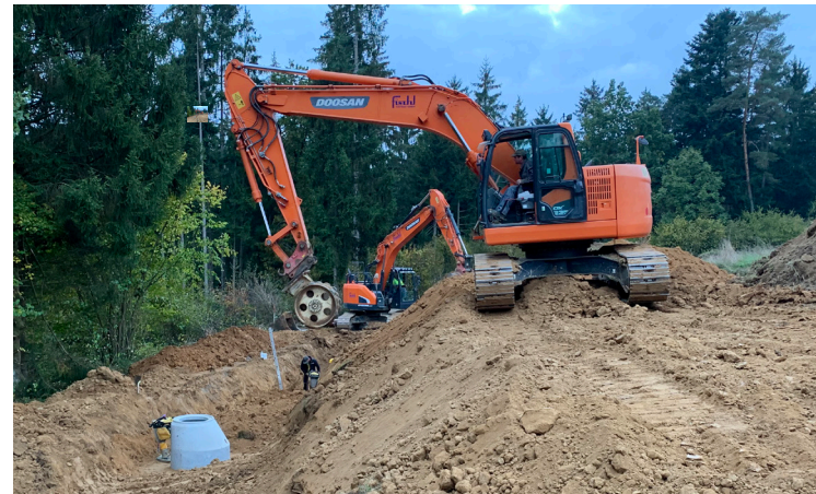
Mit der Verlegung des Schmutzwasserkanals beginnen Anfang Oktober die Bauarbeiten.
